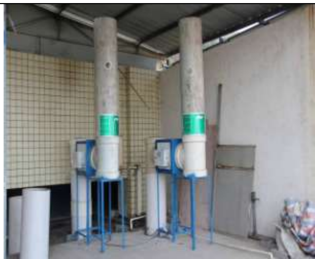
照片 6： 食堂油烟净化器和排气筒
